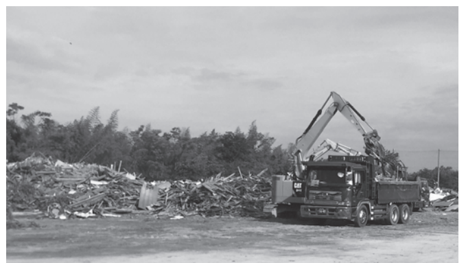
災害廃棄物の仮置き場として緑川グラウンドを利用
