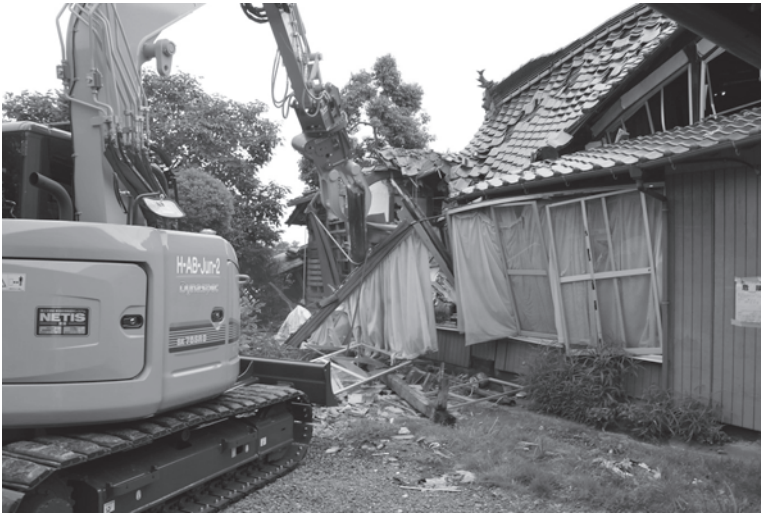
解体中の損壊家屋
