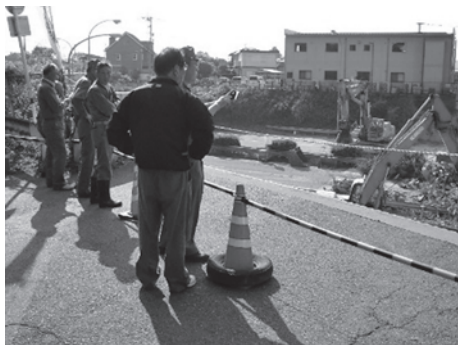
被災状況を確認する議員（府領）
