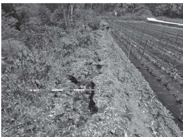
免の山の被災（亀裂）状況
