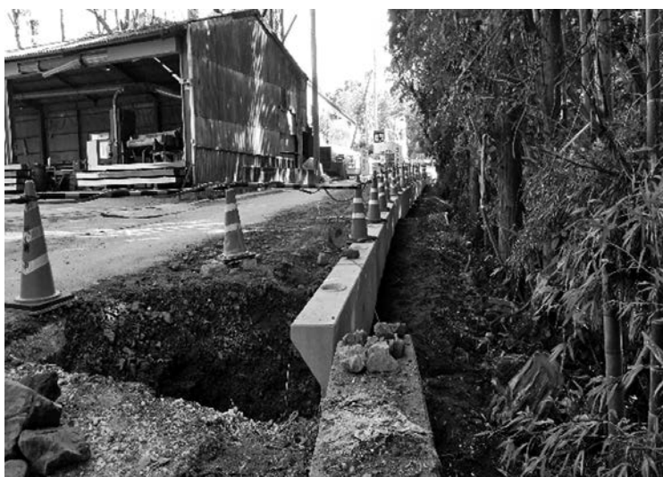
震災復旧工事が進む「ごみ焼却場」への道路 （町道松ヶ崎妙見谷線）
