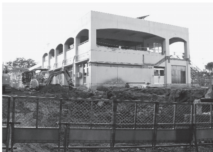
増築等工事が始まった龍野小学校校舎
