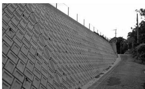
修復された宅地の擁壁 (津志田)
