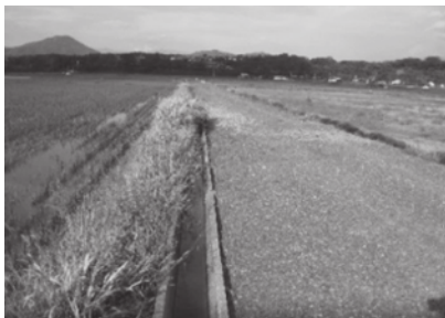
復旧工事が進む農道
