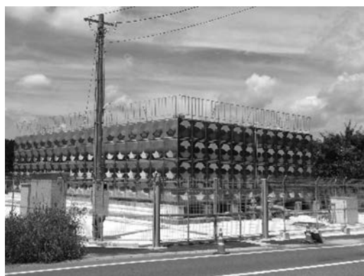
震災復旧工事が終わった世持配水場
