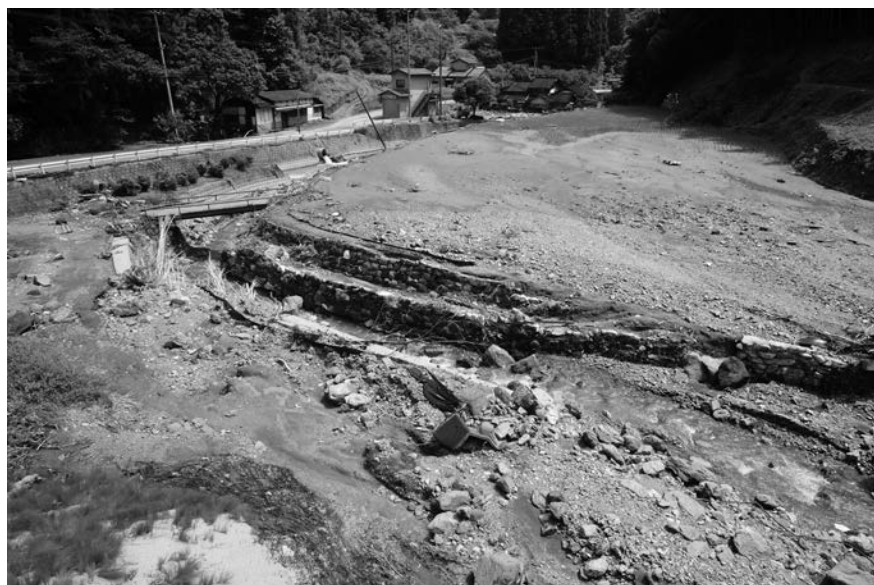
農地へ土砂が流れ込んでいる（谷内）
