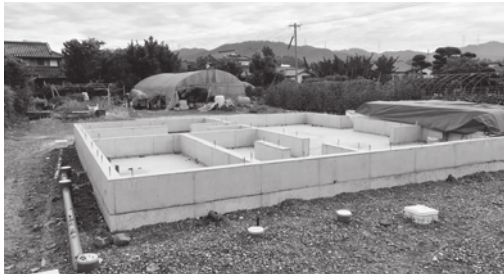
建替工事が進む住居
