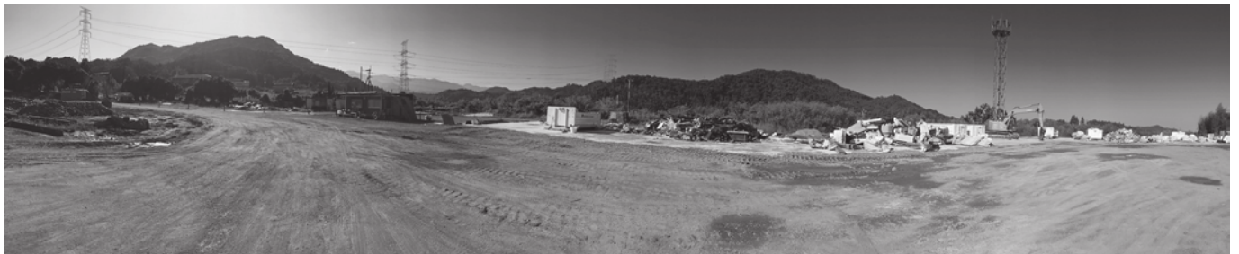
家屋の解体仮置場（西寒野）
