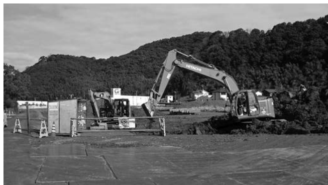
すまいの復興拠点施設整備の造成工事(豊内)
