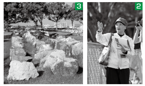
1_複数箇所ですら石垣が損壊(写真は戌亥櫓) 2_修復中の熊本城を案内するボランティアガイド 3_同じ位置に復元するため整理された崩れた石垣
