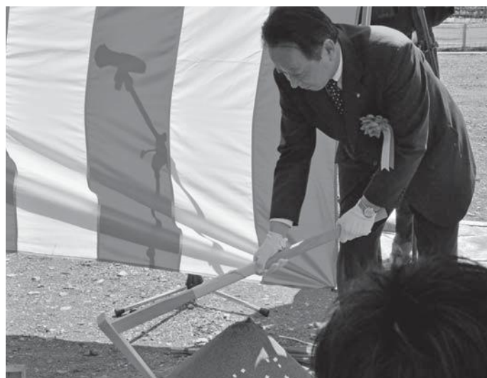
▲4月18日（水）、甲佐地区の災害公営住宅建設予定地で行われた起工式で、工事の安全を祈願する奥名町長
