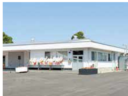
▲西寒野地内に完成した九州事業所
