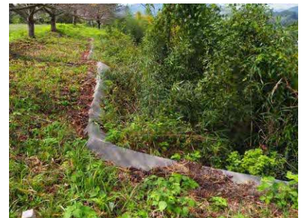
写 4-8 復旧工事箇所
