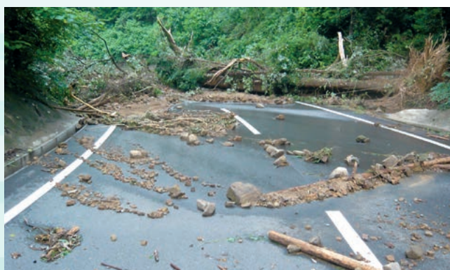
▲広域農道美里町側
