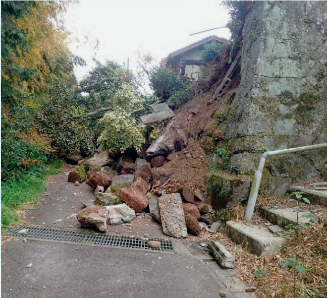
▲町道山口甲佐線ののり面崩壊
