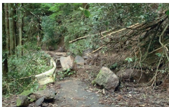
▲町道広瀬線の道路寸断
