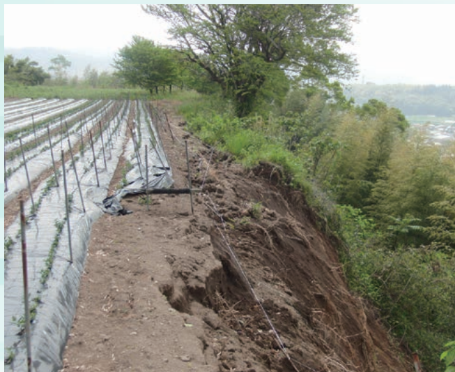
▲免の山(陣ノ内館跡)の斜面崩壊と亀裂発生
