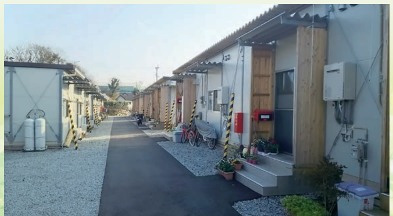
森川健康堂敷地内に建てられた仮設住宅
