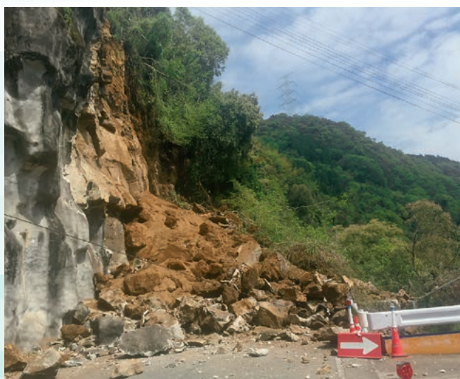
▲県道三本松甲佐線の土砂崩れ(西から)
