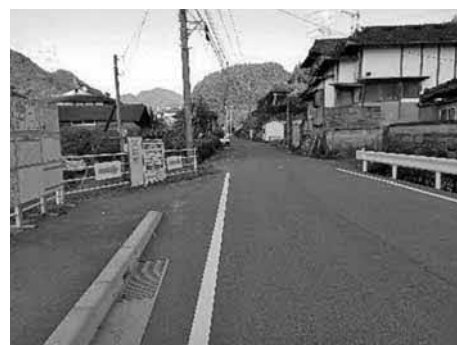
改良が進む町道西寒野打越線（白石地内）
