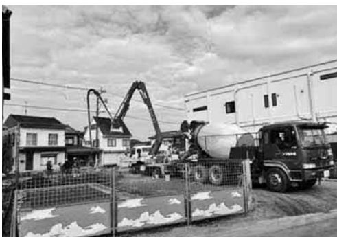
建設中の甲佐町起業等応援施設
