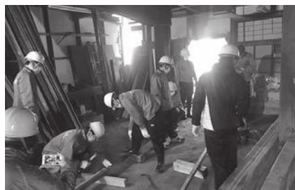
▲大工さんに教わりながら床下の木材の釘抜き作業をする甲佐高校の生徒たち
