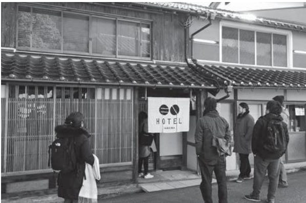
▲城下町に空き家を改修した客室が分散している朝来市
