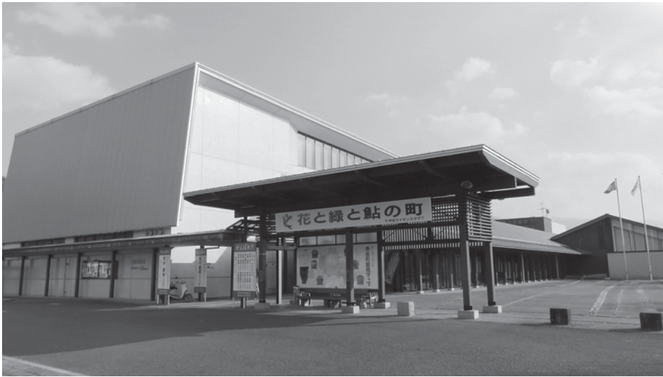
陸屋根部分の防水改修計画がある役場庁舎
