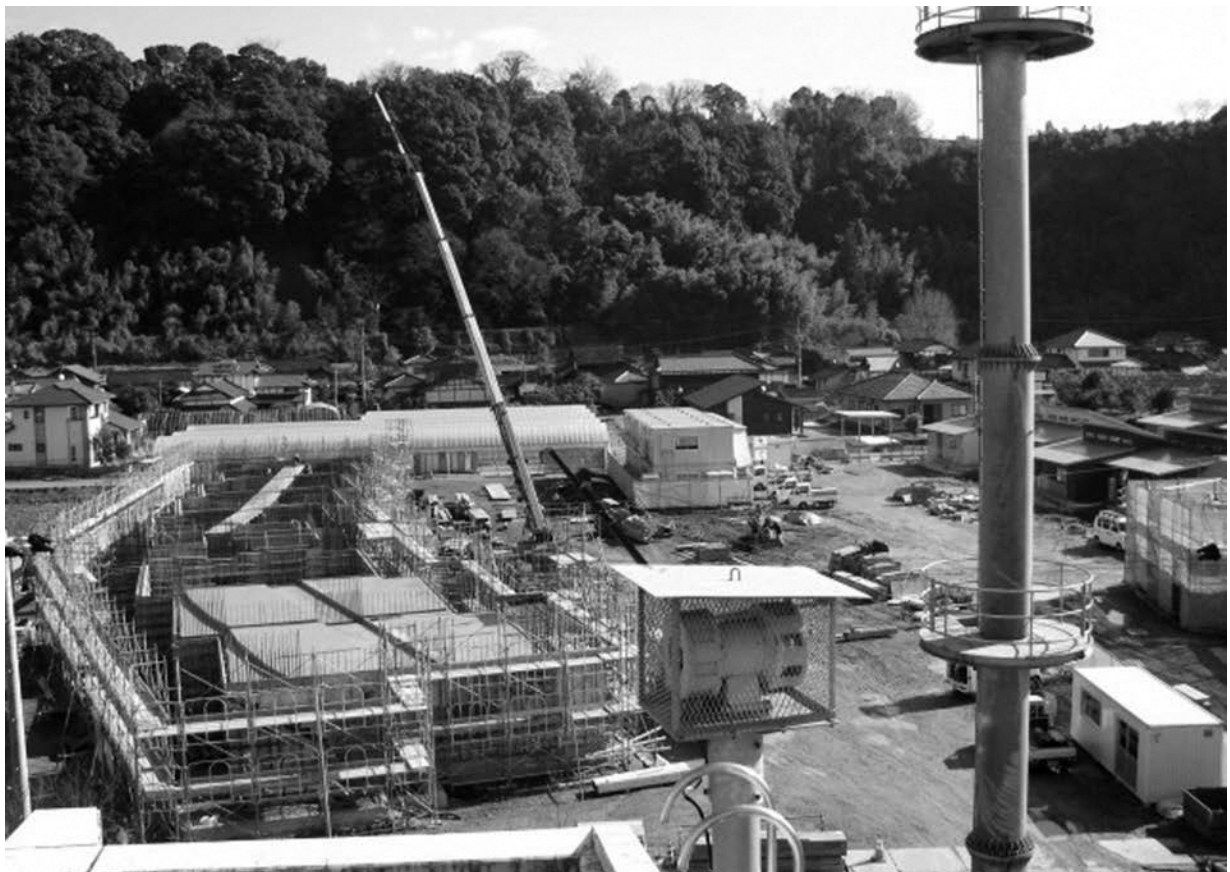
建設中の子育て支援住宅（豊内）
