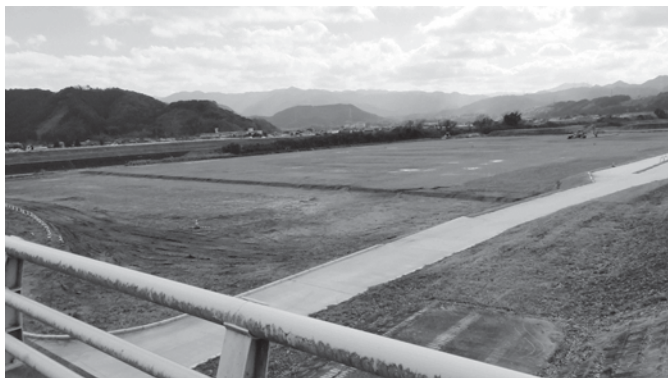
建設中の安津橋総合運動公園（仮称）
