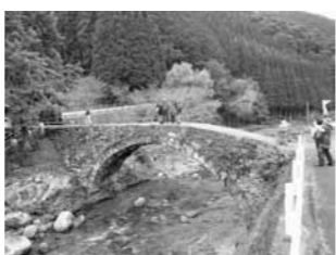
▲東陽町に流れる河俣川に架かる種山石工が造った笠松橋
