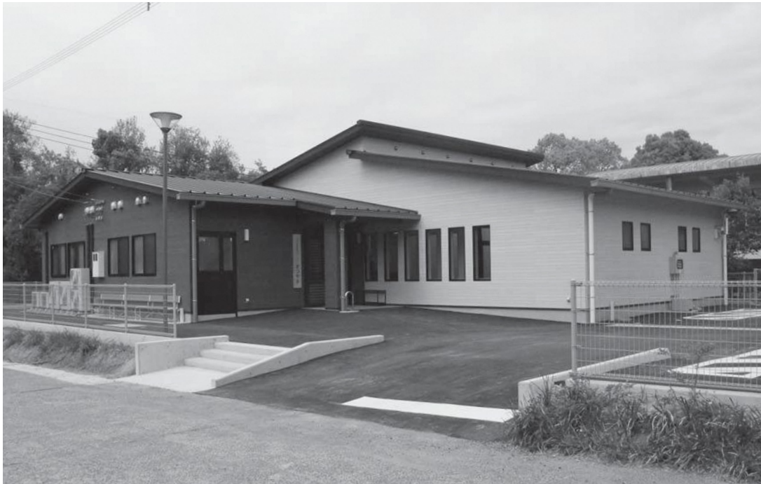
乙女小学校の東側に完成した乙女高齢者福祉センター「まつやま」
