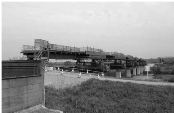
完成が待ち遠しい「田口橋」 (田口側上流から)
