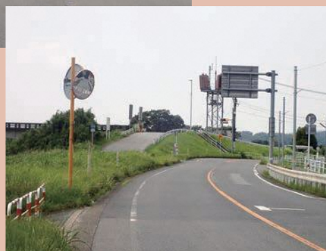
平面交差が予定されている田口橋（白旗側）
