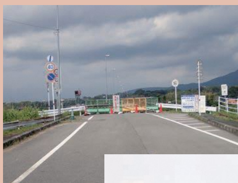
通行止めが続いている田口橋（乙女側）
