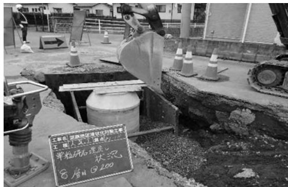
芝原液状化対策工事の様子
