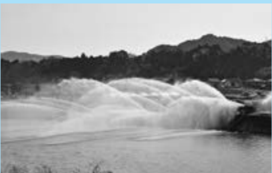
▶ 点検の後に行われた一斉放水
