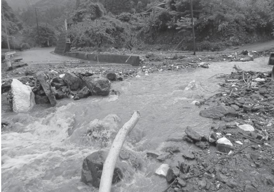
▶豪雨により寸断された道路（谷内区）
