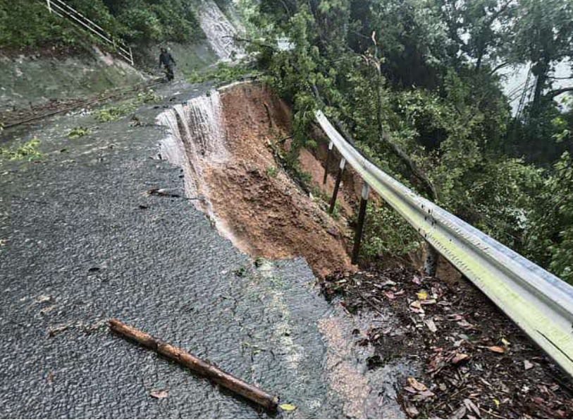
◀片側が崩落した県道稲生野甲佐線
