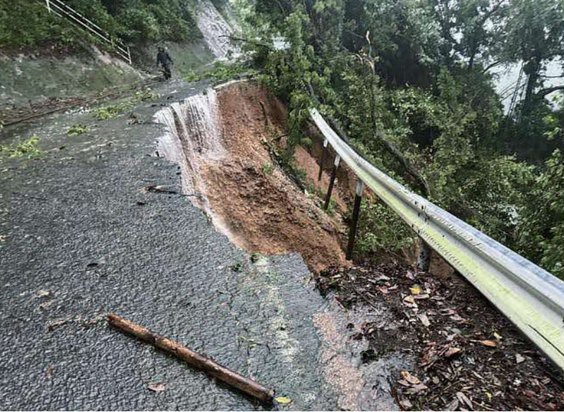
◀片側が崩落した県道稲生野甲佐線
