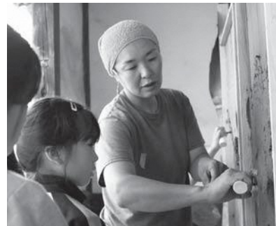
▲古民家改修ワークショップで参加者に土壁の塗り方を指導する加本さん(右)
