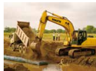
▲備蓄資材（土砂や雑割石）の活用例
