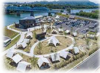
賑わい拠点の整備 (木曾川／美濃加茂市)
