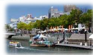
親水護岸の利用 (新町川／徳島市)
