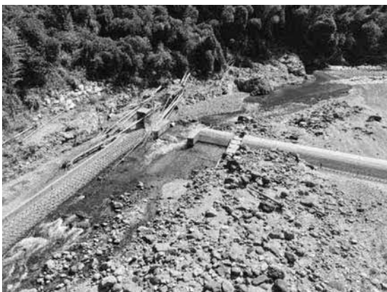
被災した鹿生田堰
