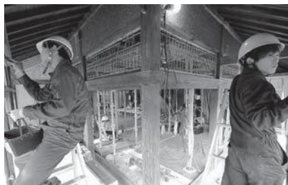
▲古民家に馴染む濃い茶色の塗料で窓枠などの建具を塗っていく参加者
