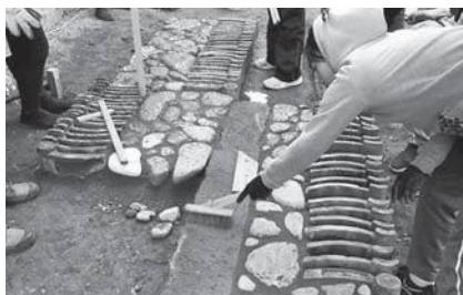
▲自然石と再利用した瓦を使った個性的な玄関アプローチが完成
