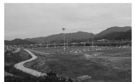
整備中の「総合運動公園」
