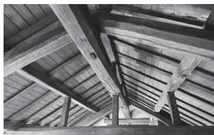
▲落ち着いた茶褐色の塗装が施された大きな梁が見える天井
