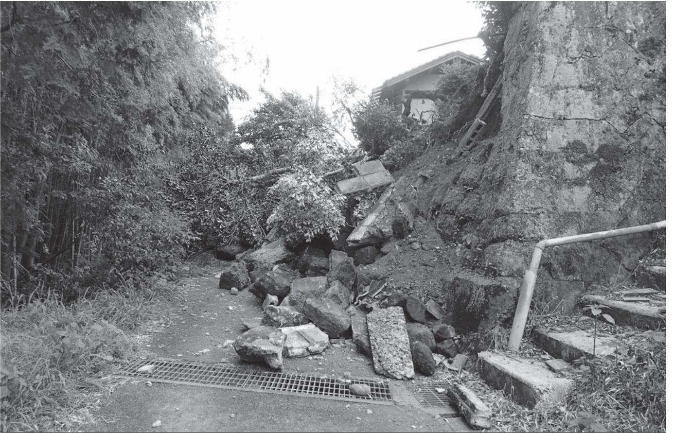
熊本地震により石垣が崩落した町道山口甲佐線（船津区）
