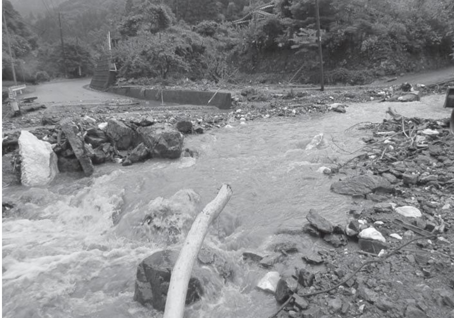
▶豪雨により寸断された道路（谷内区）
