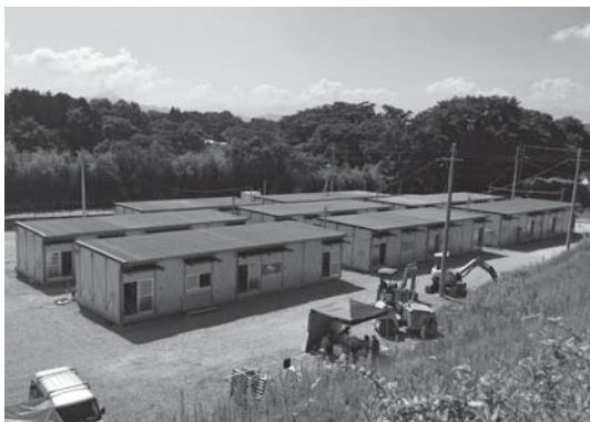
▲完成した乙女第2仮設団地(森川健康堂(株)研究棟敷地)
