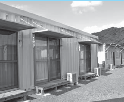
▼9月に完成した白旗第3仮設団地
