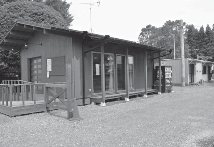
▲乙女第3仮設団地に建設された「みんなの家」談話室
