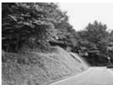
県道白旗 - 御船線沿いの断層崖 (山出神社付近)
