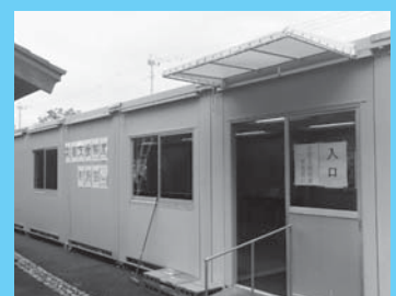
▲町庁舎南側広場に設置された仮設プレハブ
