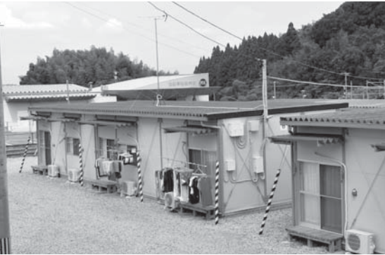
▼乙女地区と白旗地区に6団地228戸が建設された応急仮設住宅（写真は乙女第2仮設団地）
