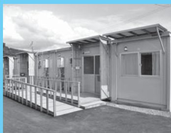
▲白旗地区に建設された白旗第3仮設団地
