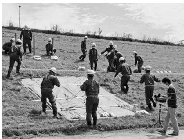
▲シート張り工法を実践する水防団員ら
