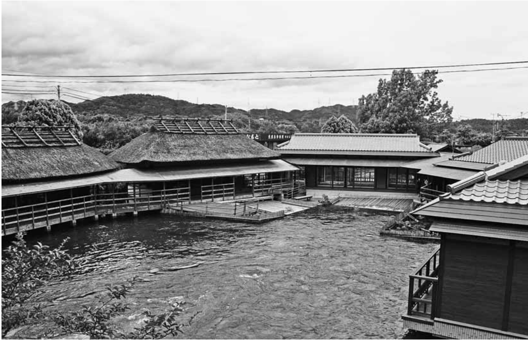
▲北側客室と西側客室が改装されてリニューアルした「やな場」
