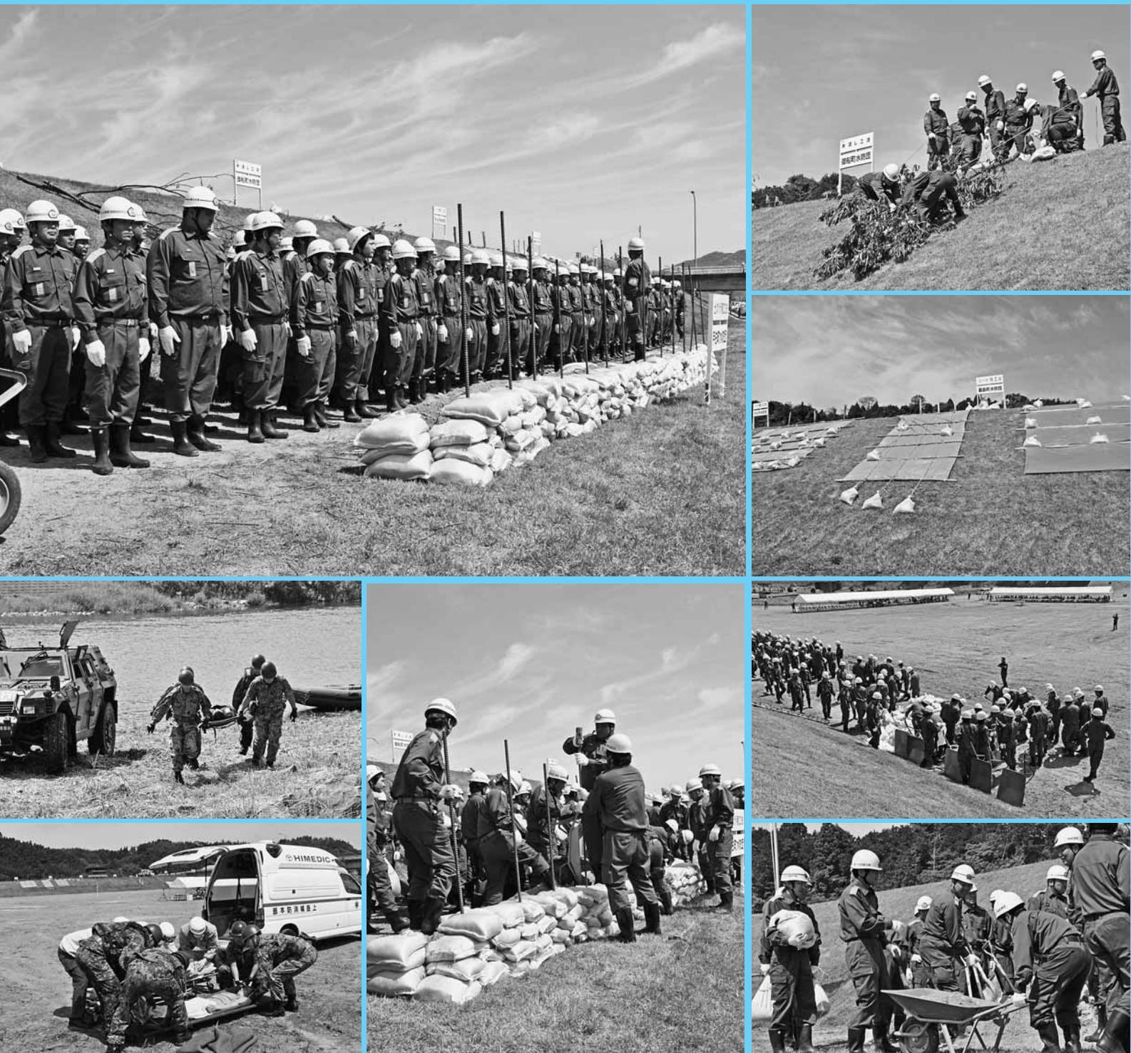
などを巡回。堤防に濁流によって削られた個所を発見したことから、本部から水防団に出動命令が出され、御船町水防団と県水防班が、枝葉の茂った樹木で削られた個所を固定する「木流し工法」を実施しました。
