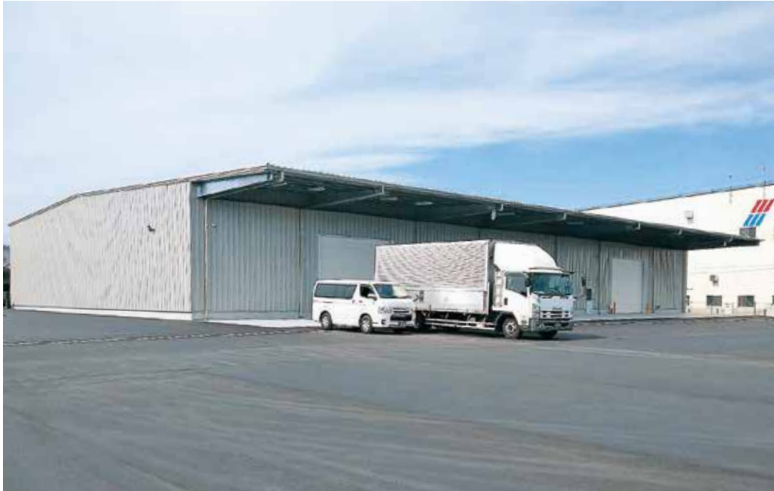
▲白旗地内に完成したダイキュー協同組合熊本事業所の物流倉庫
