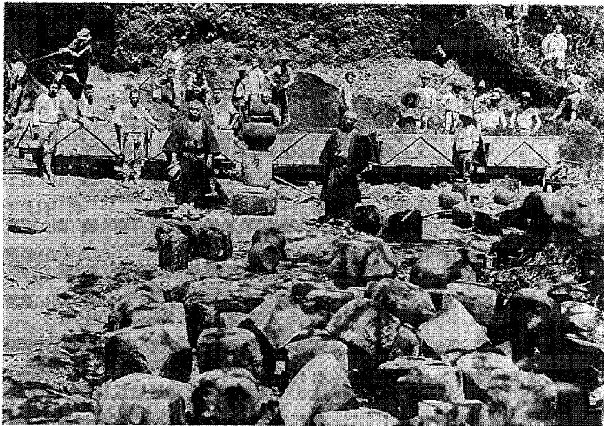
写真4-2 上豊内旧老人ホーム付近での石造物発掘状況
