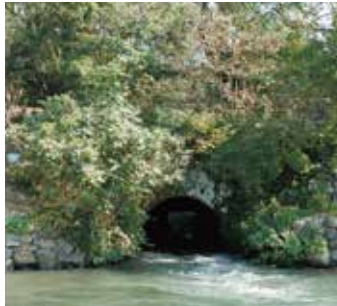
10 上豊内 築の樋門
