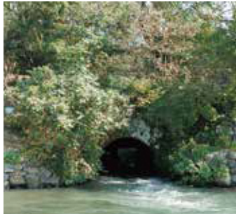
10 上豊内 築の樋門
