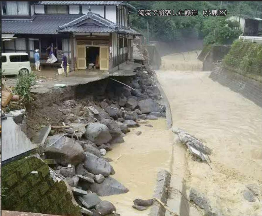
濁流で崩落した護岸 (小鹿区)
