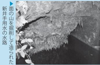
面の山を掘削して造られた新井手用水の水路
