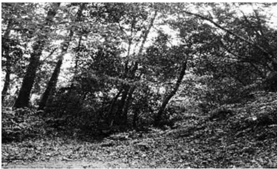
被災した作業道（船津地区）
