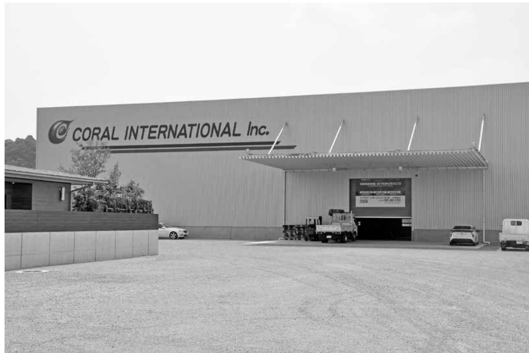
完成したコーラルインターナショナル(株)九州支社（下横田）
